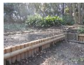
丹沢地域の間伐材を用いた丸太護岸
